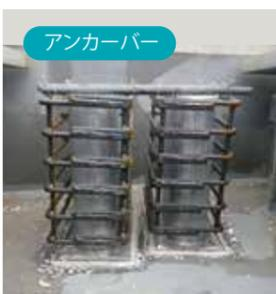
主桁の直下にパッド型ゴム支承を設置する場合は、支点上補剛材は設けませんが端横桁は省略します。主桁間にはアンカーバーを設置します。
