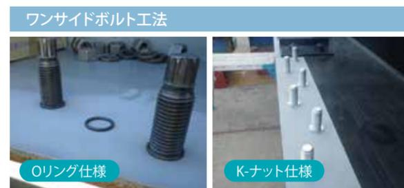
底版の橋軸方向縦継ぎ手には、ワンサイドボルト工法を採用しています。ワンサイドボルト工法では、添接作業が底版上面からのみとなるため、桁下に足場工等が不要になるメリットがあります。
