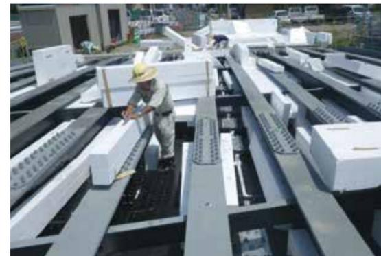
リバーブリッジの中空タイプでは、床版型枠に埋込型枠(発泡スチロール)を使用しています。発泡スチロールは軽量、不燃性に優れ、現地での加工性もよい素材です。
