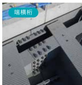
機能一体型ゴム支承を設置する場合は、各主桁の直下に支承を配置することが難しいため、端横桁を設けて、支承間隔を拡げています。
