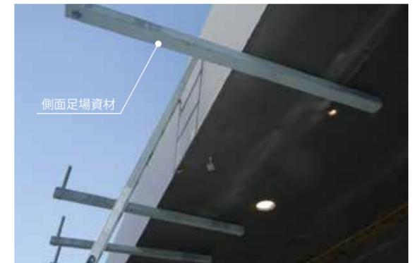
リバーブリッジでは地覆部のコンクリート施工、及び安全対策上、側面足場を標準で用意しており、桁架設時にリース品としてご提供が可能です。
